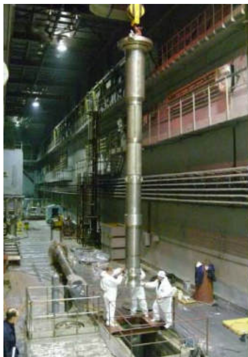
Технологический зал. Установка корпуса реактора
