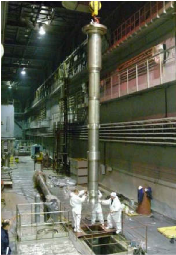
Технологический зал. Установка корпуса реактора
